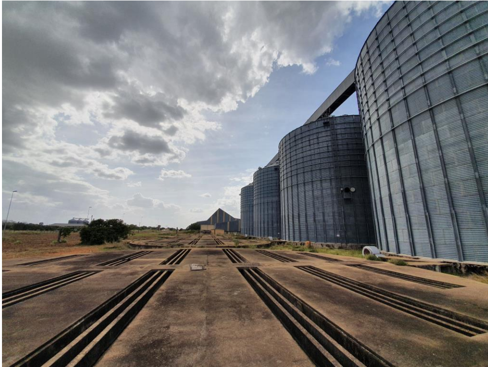
Foto 09 – Vista dos Silos de Armazenamento e 04 Bases Para novos Silos
