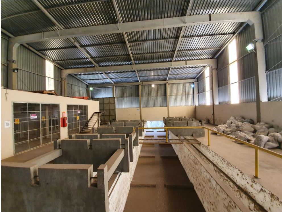
Foto 45 – Vista Interna do Galpão de Máquinas de Limpeza: Bases para Novas Máquinas
