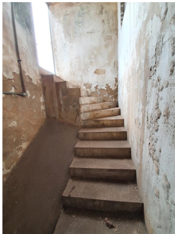
Foto 22 – Vista do Túnel dos novos 04 Silos
