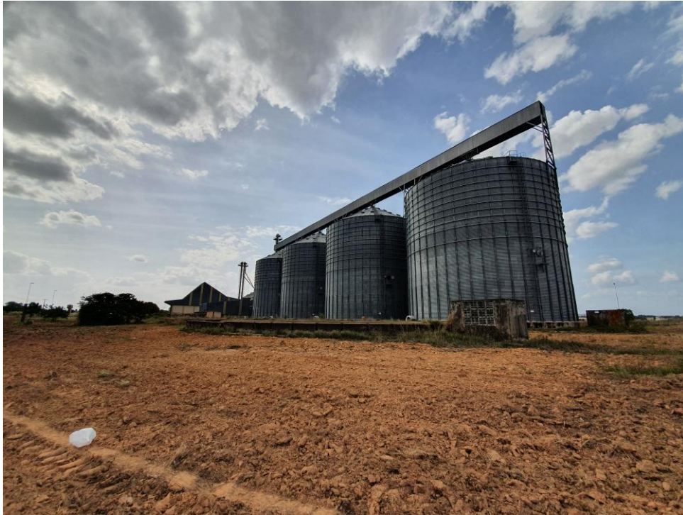
Foto 05 – Vista dos Silos de Armazenamento
