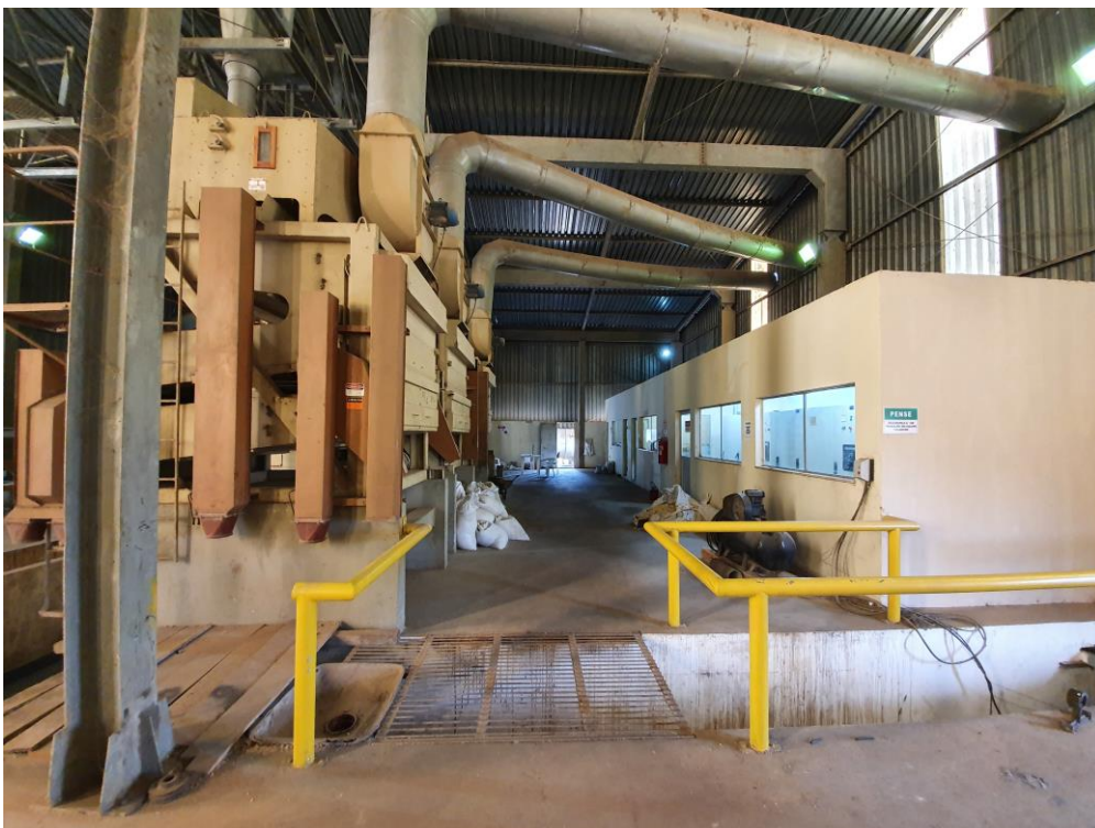
Foto 42 – Vista Interna do Galpão de Máquinas de Limpeza
