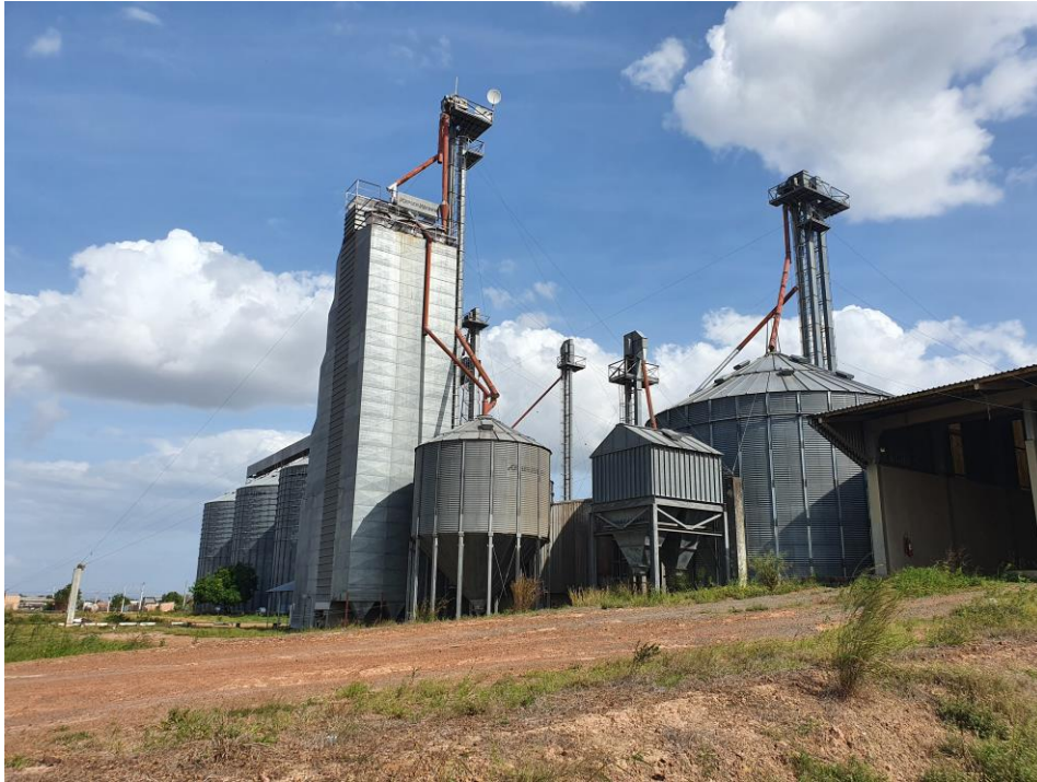
Foto 07 – Vista da Unidade de Armazenamento
