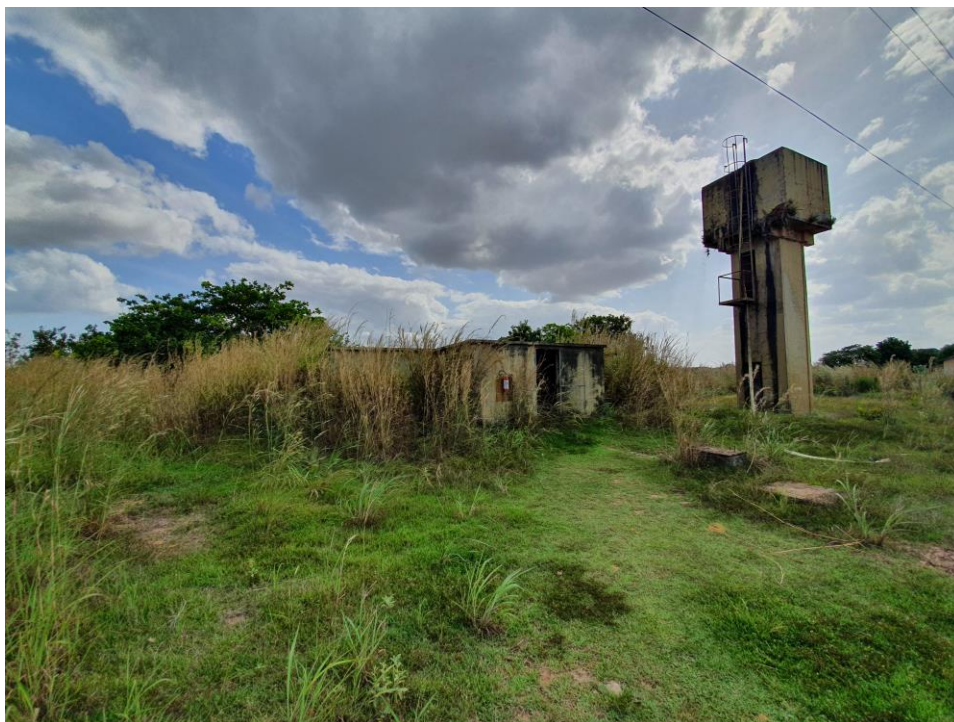
Fotos 27 e 28 – Vista da Casa de Bombas de Incêndio e Caixa D`água
