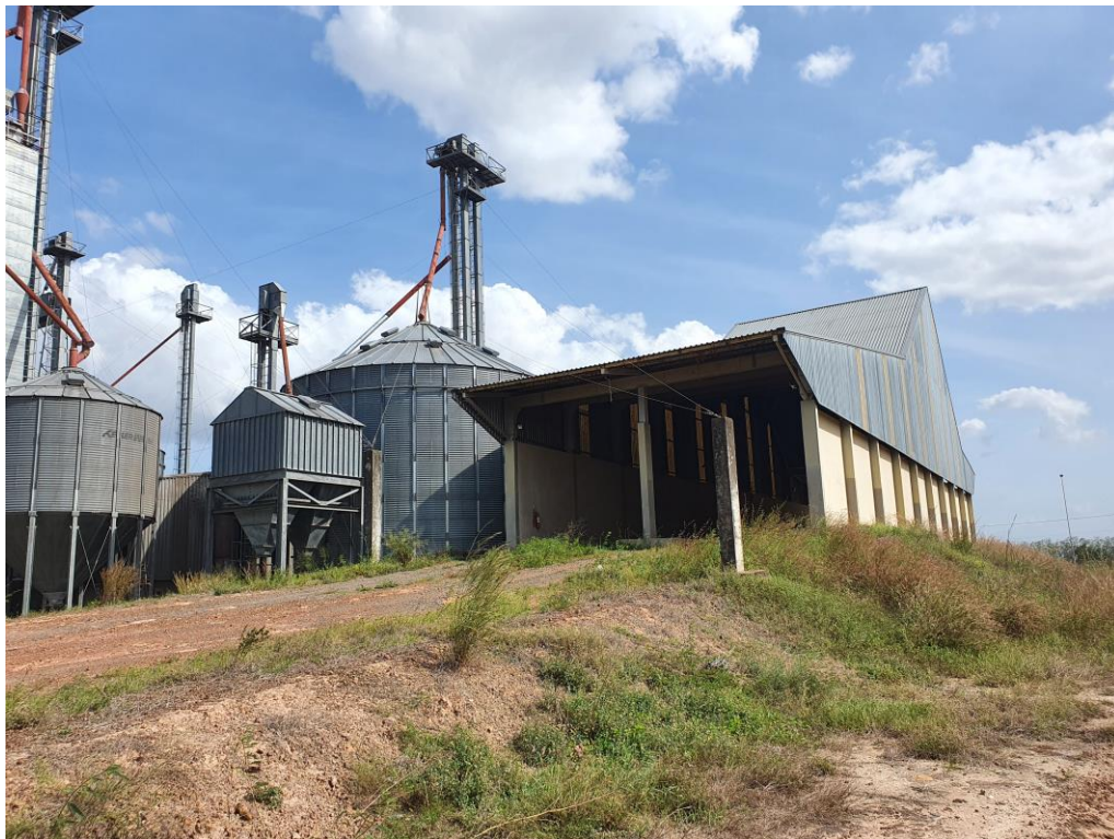
Foto 51 – Armazém do Tombador
