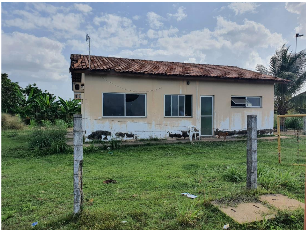
Foto 95 – Vista externa da Residência 02
