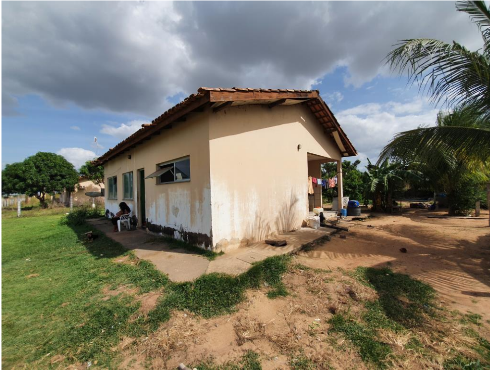
Foto 98 – Vista externa da Residência 02
