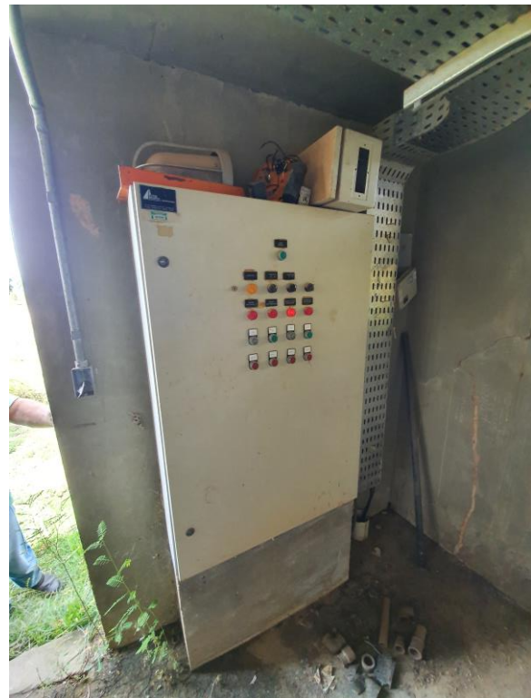
Fotos 24 e 25 – Vista da Casa de Bombas de Incêndio (Funcionando) e Quadro das Bombas
