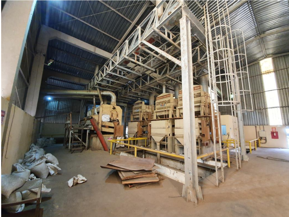
Foto 43 – Vista Interna do Galpão de Máquinas de Limpeza: Máquinas
