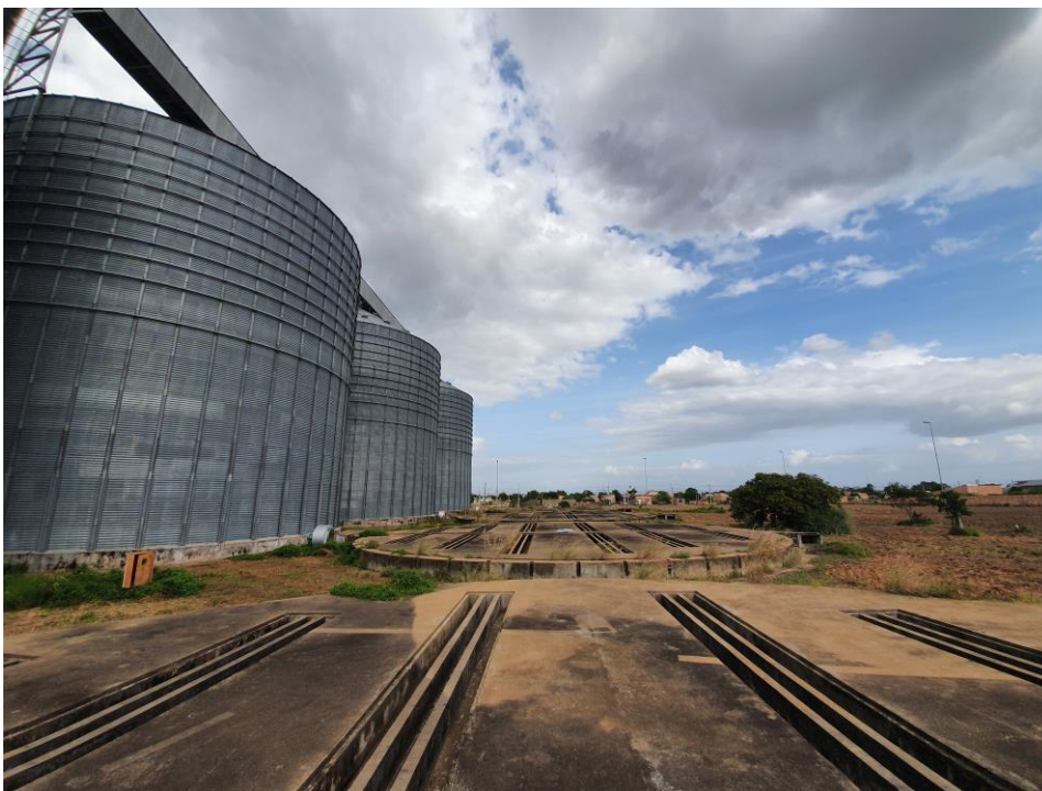
Foto 08 – Vista dos Silos de Armazenamento e 04 Bases Para novos Silos
