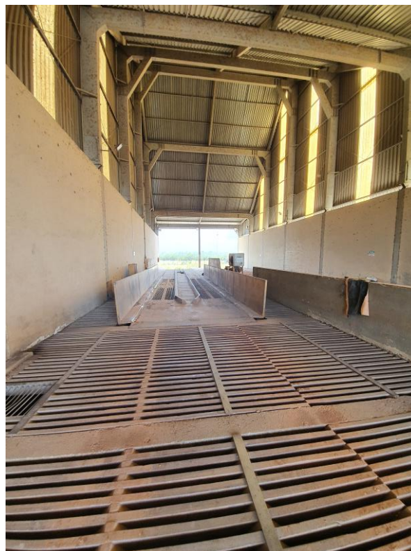
Foto 53 – Armazém do Tombador: Moega e Tombador
