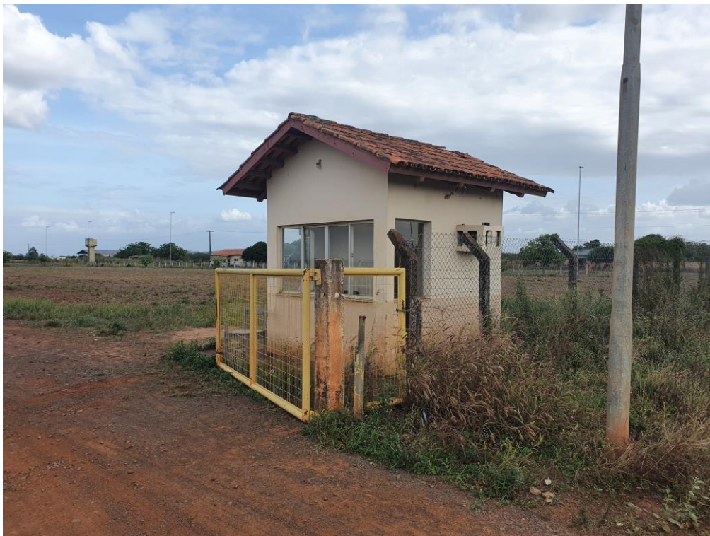
Foto 33 – Vista da Guarita
