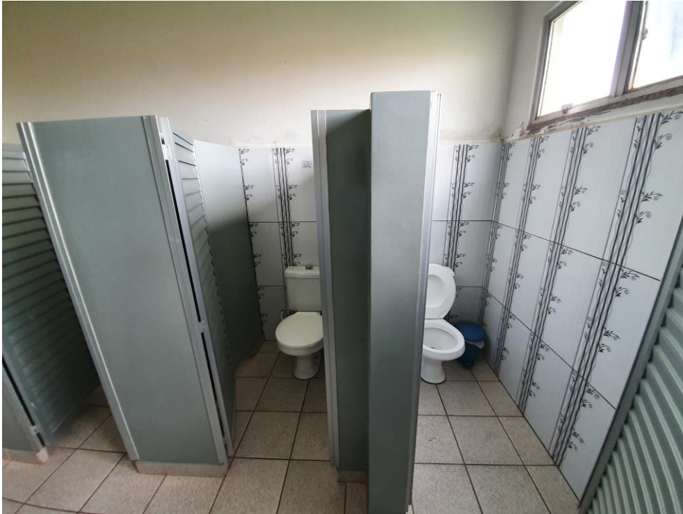
Foto 77 – Administração: Banheiro Coletivo Masculino
