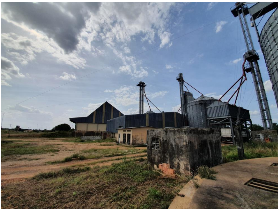
Foto 10 – Vista da Tulha de Expedição, Acesso ao Túnel dos 04 Silos (Ampliações)
