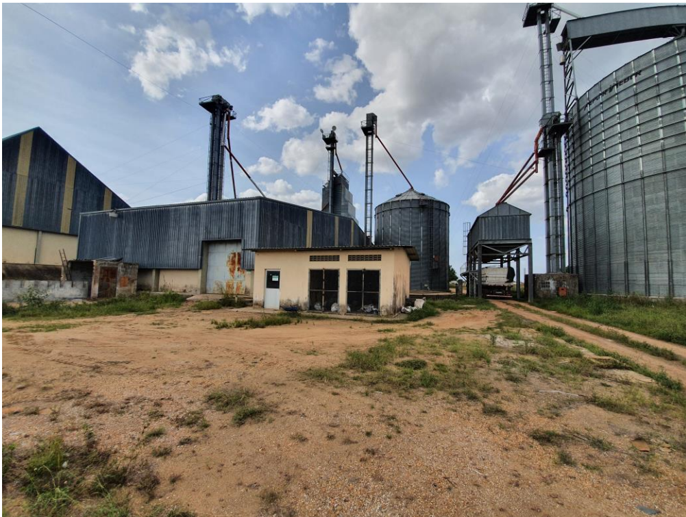
Foto 38 – Vista da Casa de Força, Galpão de Máquinas de Limpeza e Tulha de Expedição
