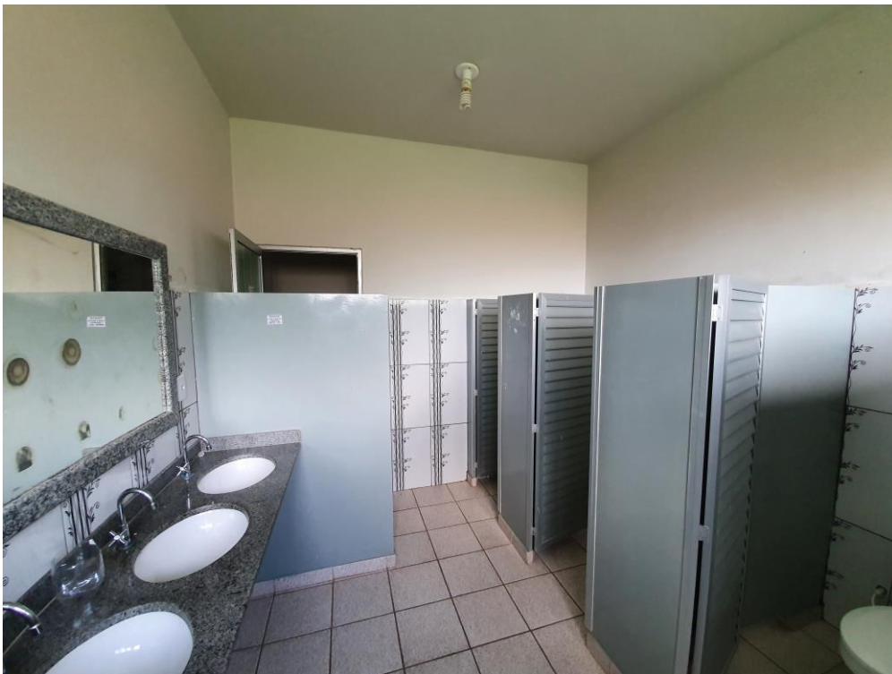
Foto 78 – Administração: Banheiro Coletivo Masculino
