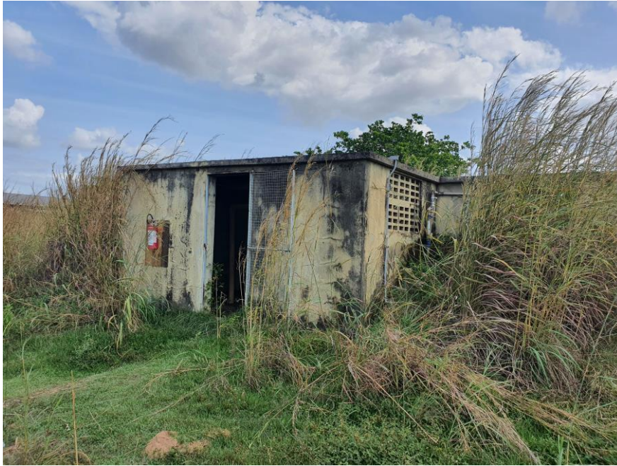
Foto 23 – Vista da Casa de Bombas de Incêndio (Funcionando)
