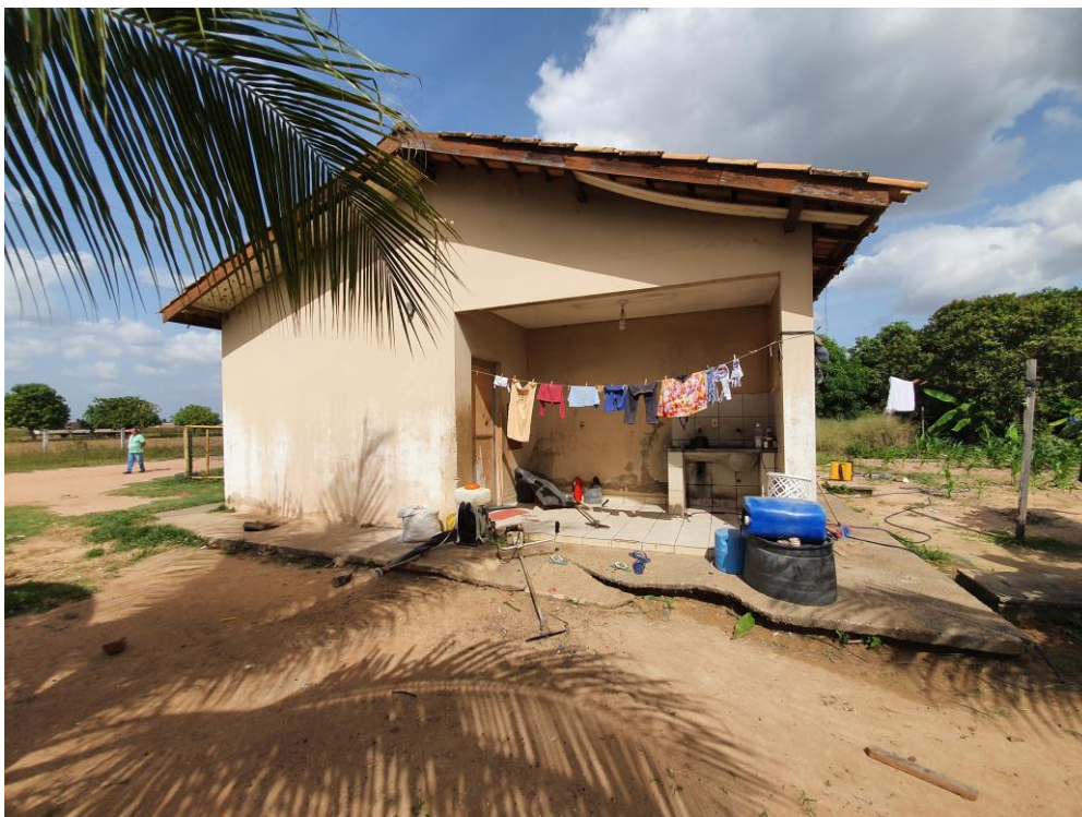
Foto 99 – Vista externa da Residência 02: Área de Serviço
