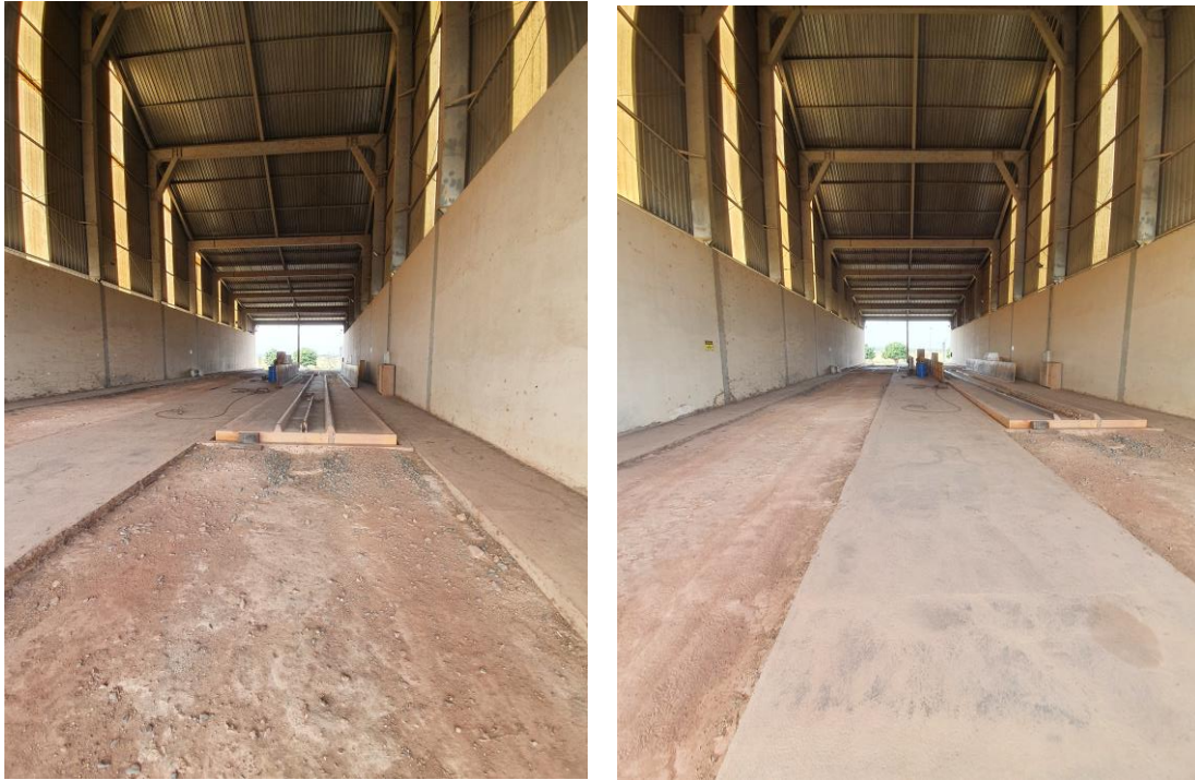
Foto 52 – Armazém do Tombador
