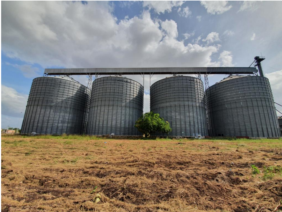
Foto 02 – Vista dos Silos de Armazenamento
