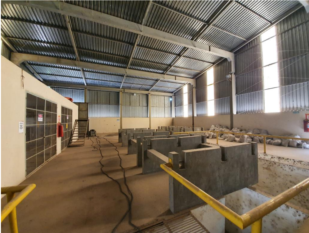
Foto 41 – Vista Interna do Galpão de Máquinas de Limpeza
