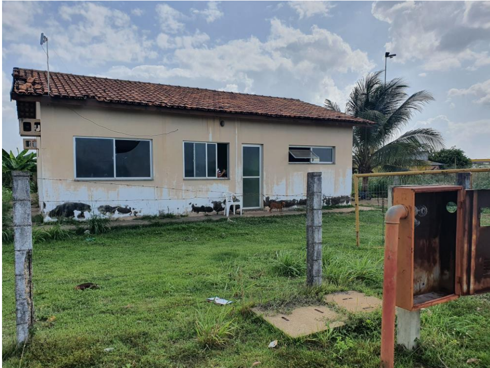
Foto 96 – Vista externa da Residência 02
