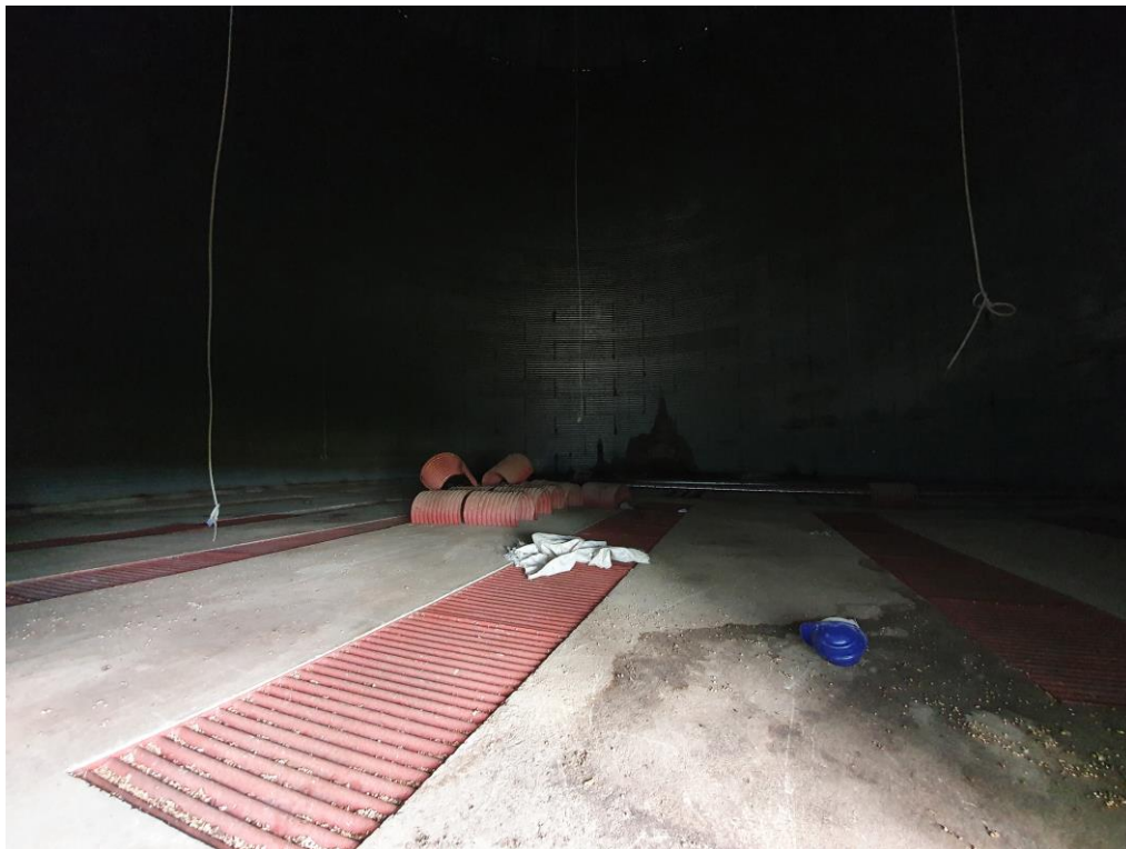
Foto 19 – Vista Interna – Silo de Estocagem
