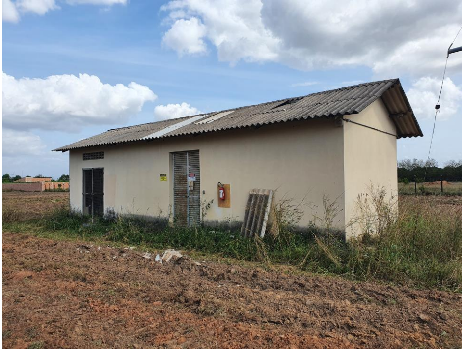
Foto 34 – Vista da Casa de Força (Grupo Gerador)
