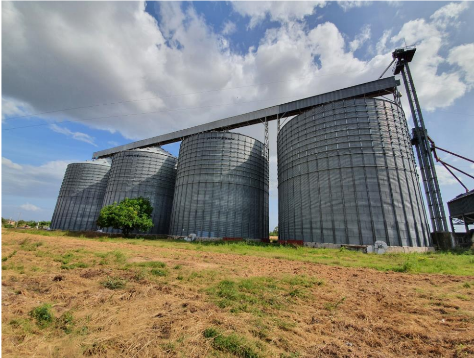
Foto 03 – Vista dos Silos de Armazenamento
