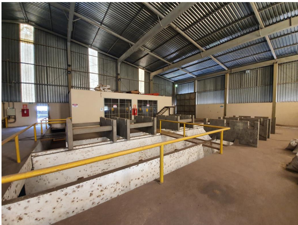
Foto 44 – Vista Interna do Galpão de Máquinas de Limpeza: Bases para Novas Máquinas
