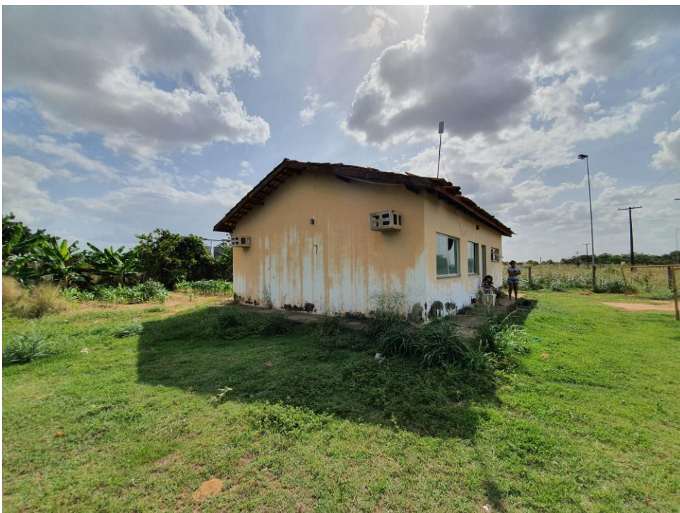
Foto 97 – Vista externa da Residência 02
