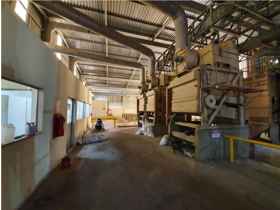
Foto 39 – Vista Interna do Galpão de Máquinas de Limpeza
