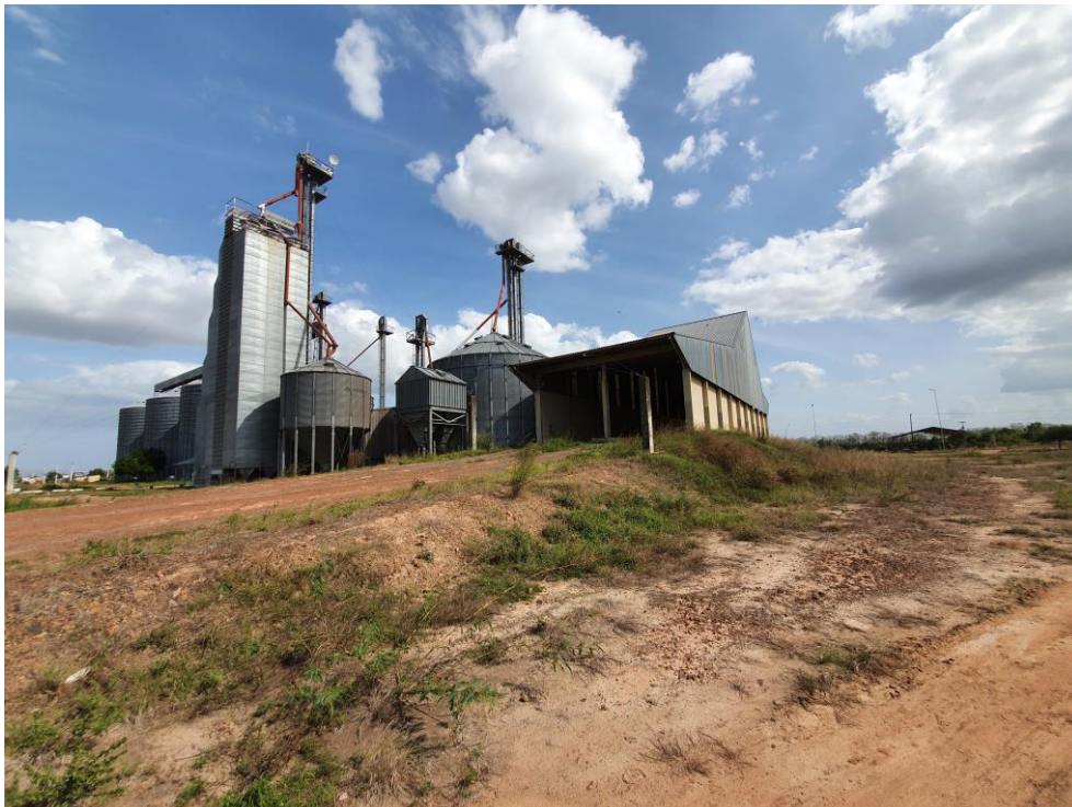
Foto 06 – Vista da Unidade de Armazenamento
