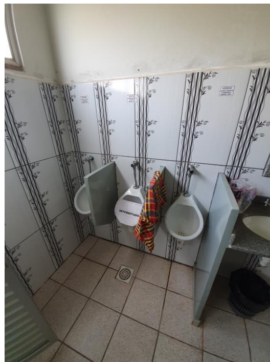
Foto 76 – Administração: Banheiro Coletivo Masculino
