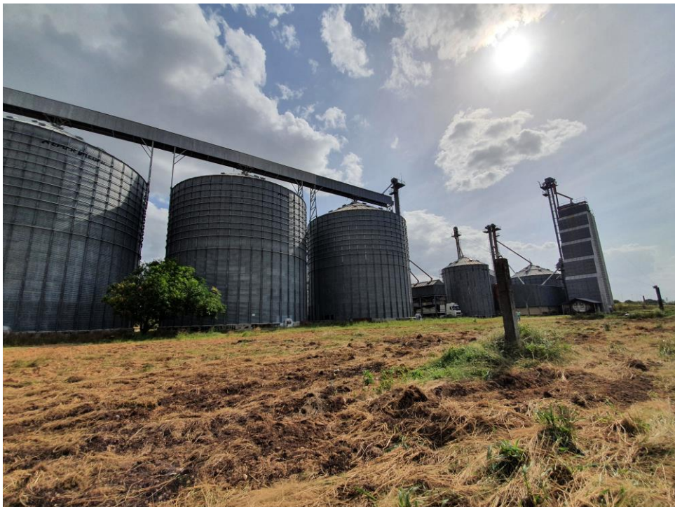
Foto 04 – Vista dos Silos de Armazenamento
