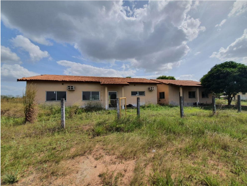
Foto 83 – Vista externa do Refeitório e Residência 01
