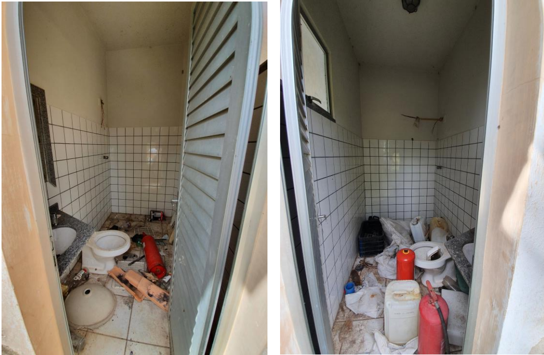
Fotos 93 e 94 –Residência 01: Banheiro Interno e Banheiro Externo
