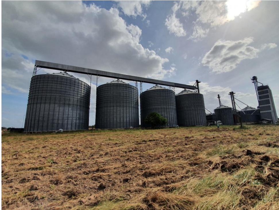
Foto 01 – Vista dos Silos de Armazenamento
